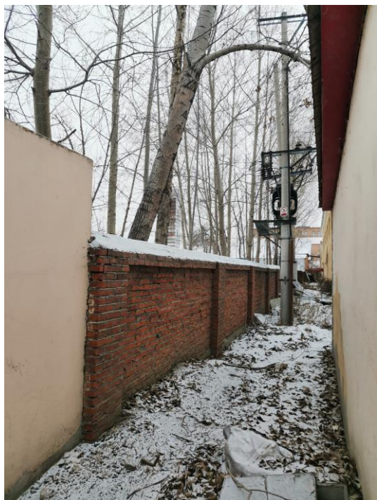
蜂业锅炉房东面
