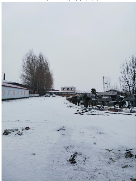
蜂业锅炉房西面
