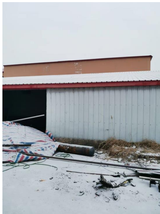
蜂业锅炉房南面
